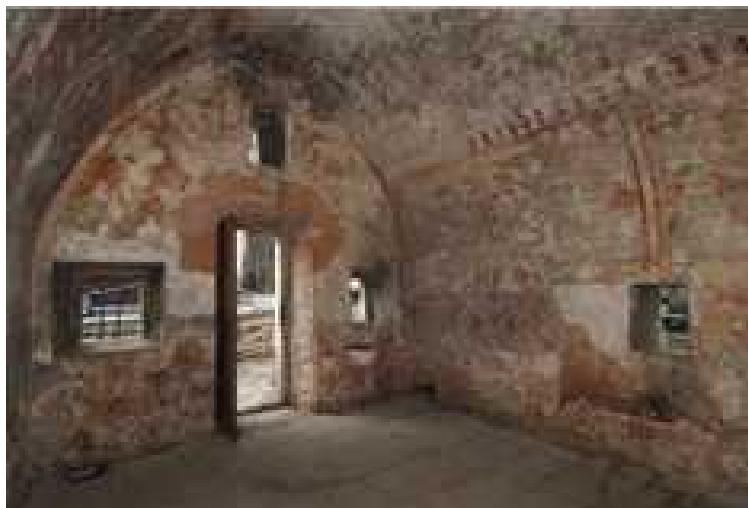
Sl. 31. Pogled prema sjeverozapadu
