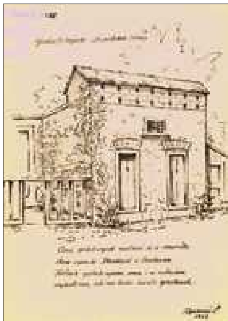
Slika 6. Golubinjak-Barban (Istra). Ovaj golubinjak nalazi se u dvorištu stare zgrade Stanković u Barbanu. Sličnih golubinjaka ima i u ostalim mjestima, ali ne tako čvrsto izgrađenih.
