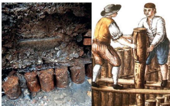
Slika 2. Postavljanje drvenih stupova u morski mulj (osnova za temelje građevina)
